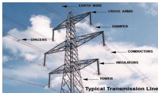
Gambar 1.10. Saluran Transmisi Listrik Udara Tegangan Ekstra Tinggi
